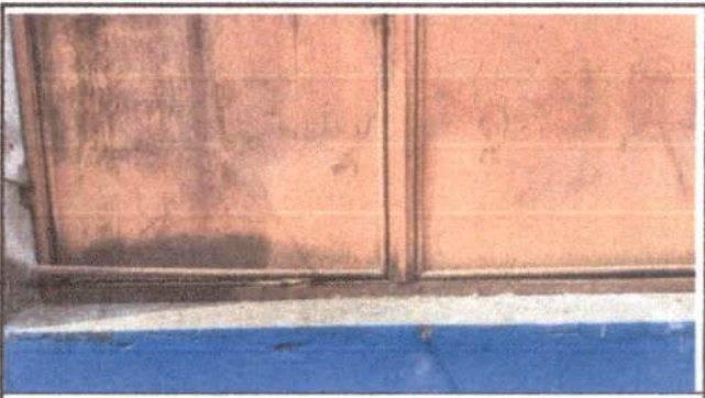
Foto 8: ventana y balcon
